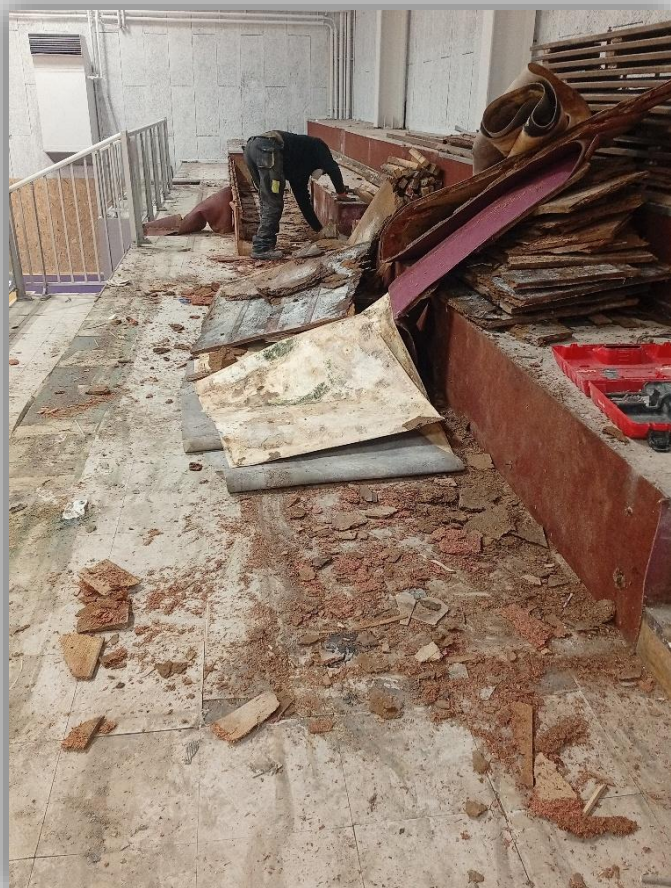
Photos des tribunes (avant désamiantage)
