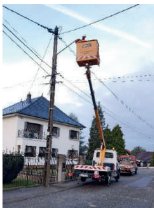
Pose d'une nouvelle lampe sur poteau béton
