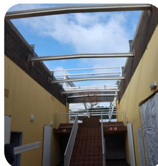
**Pendant** : réhausse des murs et montage structure métallique
